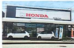
14 袋井川井店 〒437-0064 静岡県袋井市川井933-1 ☎ 0538-43-3533
