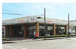
⑧ 雄踏店 〒431-0103 静岡県浜松市中央区雄踏1-22-33 ☎ 053-592-3306
