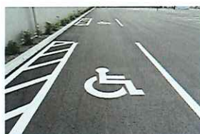
車椅子用駐車スペース
